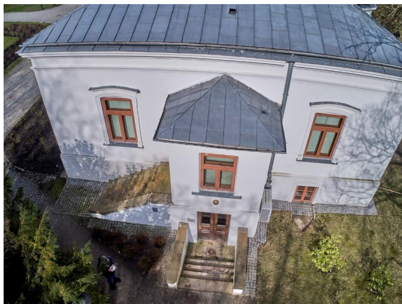
Zdj. 2 Elewacja południowa
