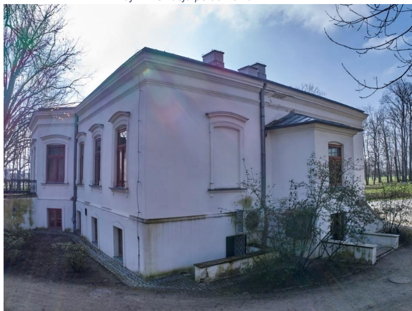
Zdj. 3 Elewacja północna
