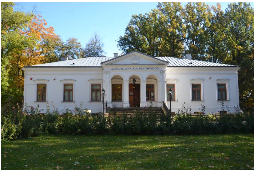
Zdj. 3 Elewacja zachodnia
