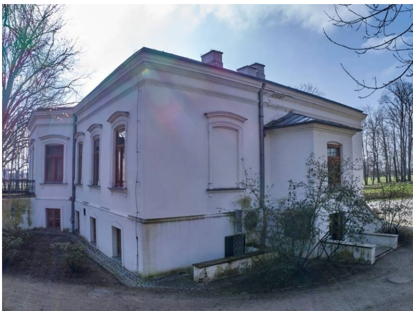
Zdj. 3 Elewacja północna
