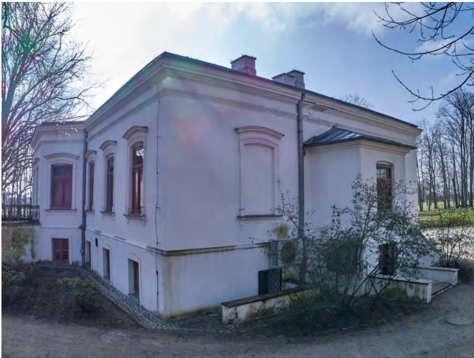
Zdj. 3 Elewacja północna i schody nr 3 i 4
