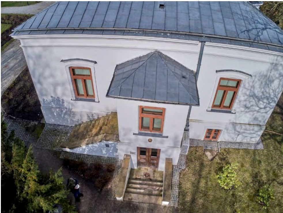
Zdj. 2 Elewacja południowa i schody nr 6 i 7
