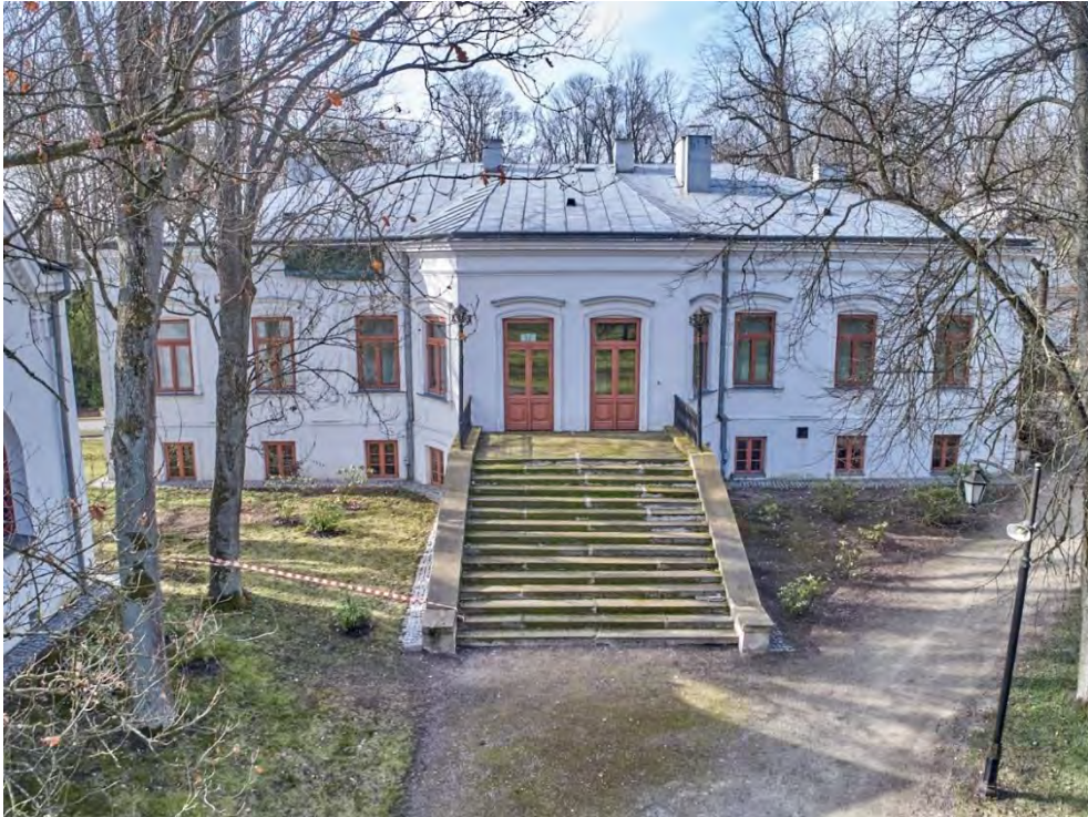
Zdj. 1 Schody nr 5 na elewacji wschodniej
